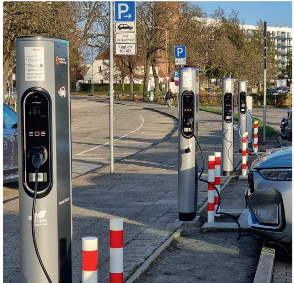
sich per RFID-Karte oder App an, verbindet das Fahrzeug mit der Station (meist Typ-2-Steckdose) und startet den Ladevorgang. Die Abrechnung erfolgt über die App oder monatlich. Nach Abschluss wird das Kabel automatisch entriegelt und kann entfernt werden.
